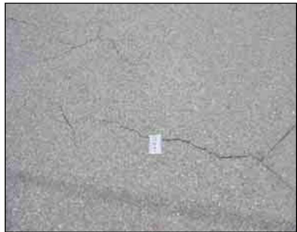
図-13 ひび割れ幅の測定(正射影変換後)
